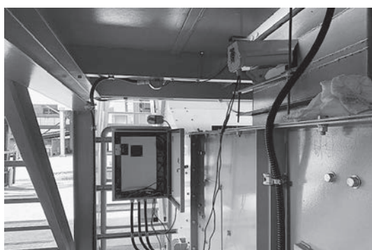
図-7 破砕機におけるSpark Eye™設置完了の様子
