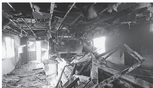
写真-1 リチウムイオン電池の発火が原因でリサイクル工場の建屋・設備の火災事例
